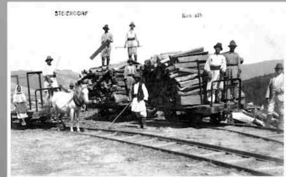
Holzbeladung auf der Forstbahn bei Rául Alb
