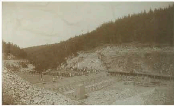
Bau des Stausee-Damms Bohui, 1908
