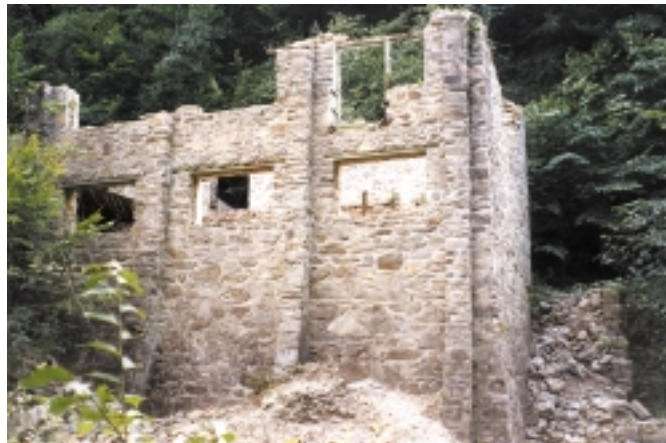
Ruine der Talstation.
