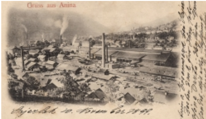
Gesamtansicht der Aninaer Industrieanlagen. AK geschrieben am 20.11.1899 von Carl Engelmann aus Steierdorf
