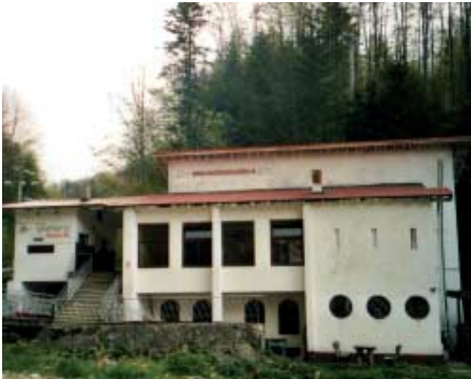
Die Talstation der Seilbahn am Muntele Mic
