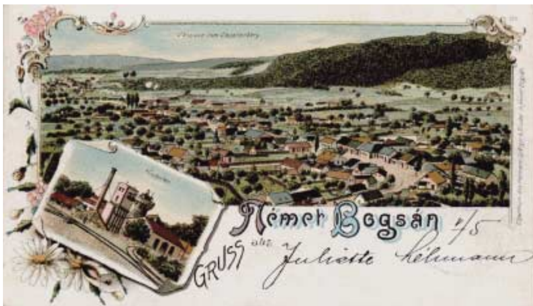
Bild 1: Totalansicht von Vasiova mit Neuwerk links im Hintergrund. Im kleinen Bild der Hochöfen am Deutsch-Bokschaner Bahnhof.
