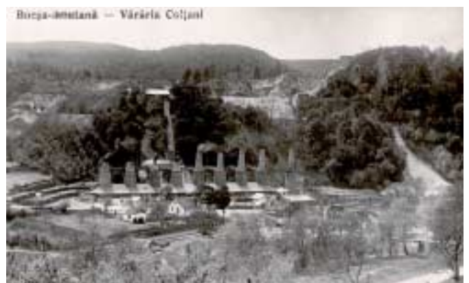
Bild 8: Gesamtansicht von Colțan in den 1930er Jahren mit allen 9 Öfen und dem Steinbruch im Hintergrund. Die 4 alten Öfen wurden später modernisiert.
