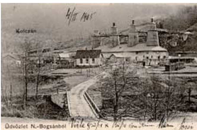
Bild 7: Die Kalkbrennerei aus Colțan im Jahr 1905. Der 4. Kalkofen wird gerade errichtet.
