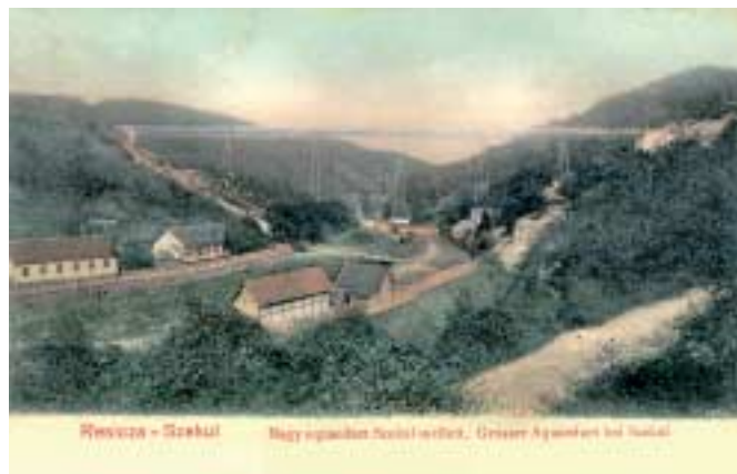
Bild 2 – Bunte Ansichtskarte von 1905. Der Sekuler Aquädukt ist in voller Länge (216 m) und Höhe (52 m) zu sehen. Darunter verläuft die Werkbahnlinie nach Reschitz, links auf dem Hang befindet sich der Friedhof und rechts oben am Kopf der Kanalbrücke der Sekuler Hafen. Wie in der rechten unteren Ecke zu erkennen, war zu diesem Zeitpunkt die Eisenbahnlinie hinauf zum Hafen noch nicht verlegt, es gab nur eine Straße.
