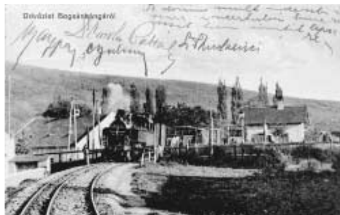
Bild 3 (links). Teilansicht der Eisenbahnstrecke zwischen Colțan und Moniom vom September 1905. Deutlich zu erkennen ist das Gleis mit nur 2 Schienen für die Werkspur von 948 mm.
