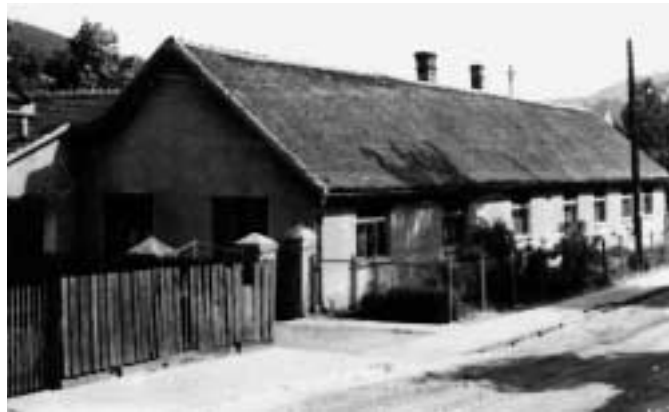
Die Sekuler Schule 1967/1968 nach Einbau der sieben dreiflügeligen Fenster
