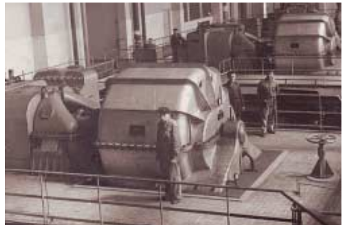
CET Sufiante Reschitza, Stromgeneratoren ca. 1964.
