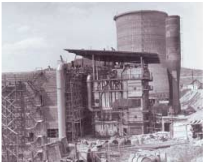
CET Sufiante Reschitza, Bauphase ca. 1960. Foto: Sammlung Woth
