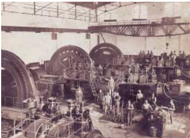
Gaszentrale Reschitza, Motoren 2, 3 und 4, ca. 1928. Foto: Sammlung Woth
